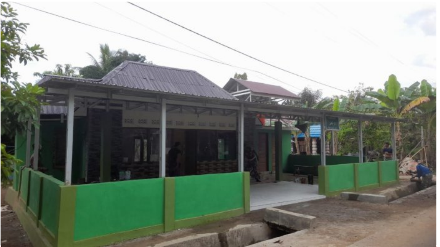
TMMD ke-116 Kodim HST Rampungkan Rehab Darul Khair
