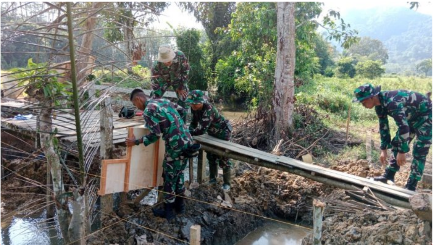
Satgas TMMMD ke-116 Kodim 1002/HST Dikerjakan Jembatan
