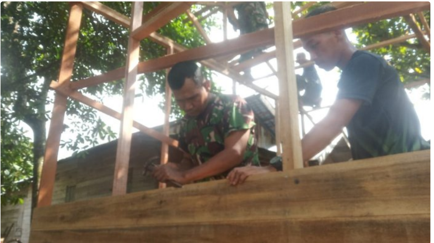
Rehab Tidak Layak Huni TMMMD Ke-116 Kodim HST Pasang Dinding Dan Lantai Rumah
