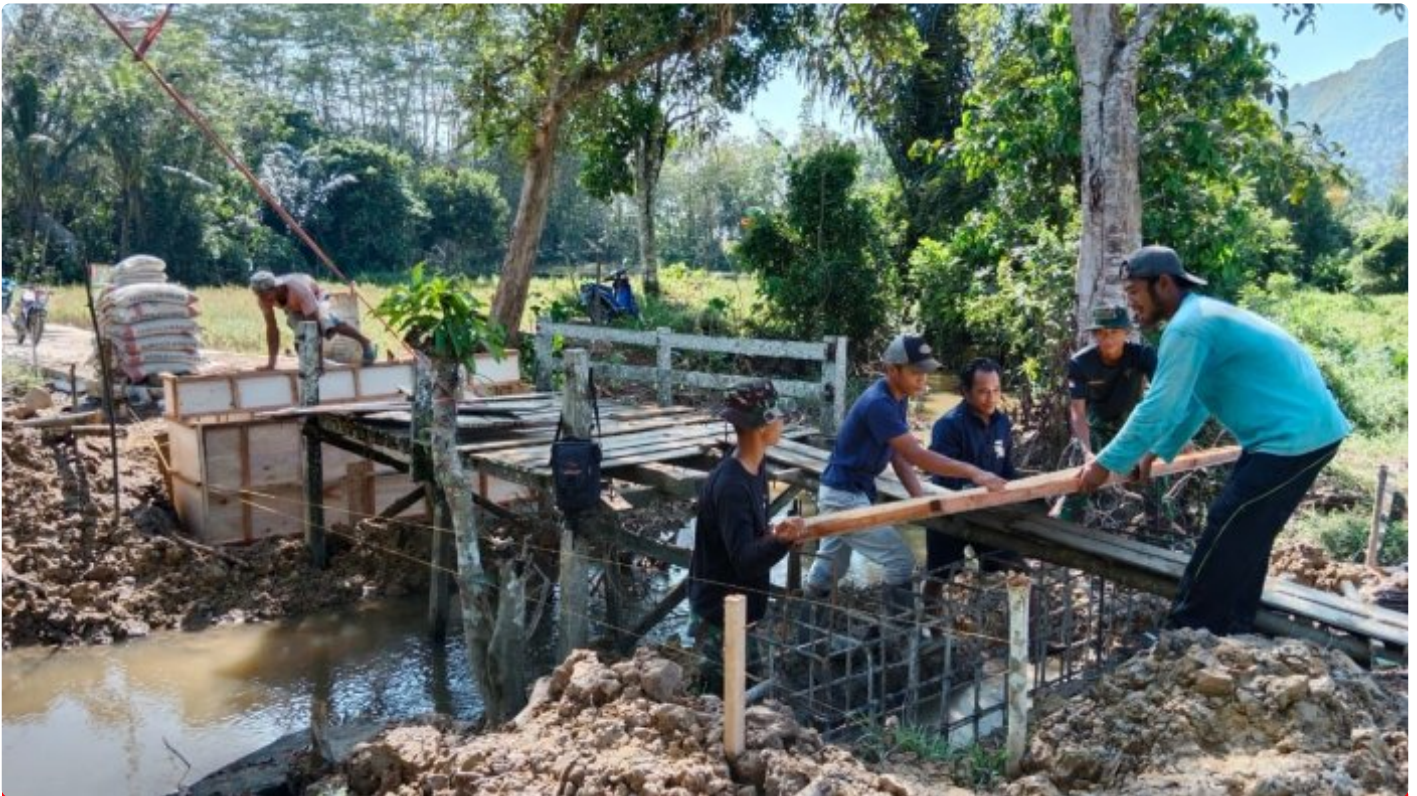
Progres Pengerjaan Jembatan, Satgas TMMD Cor Abutment
