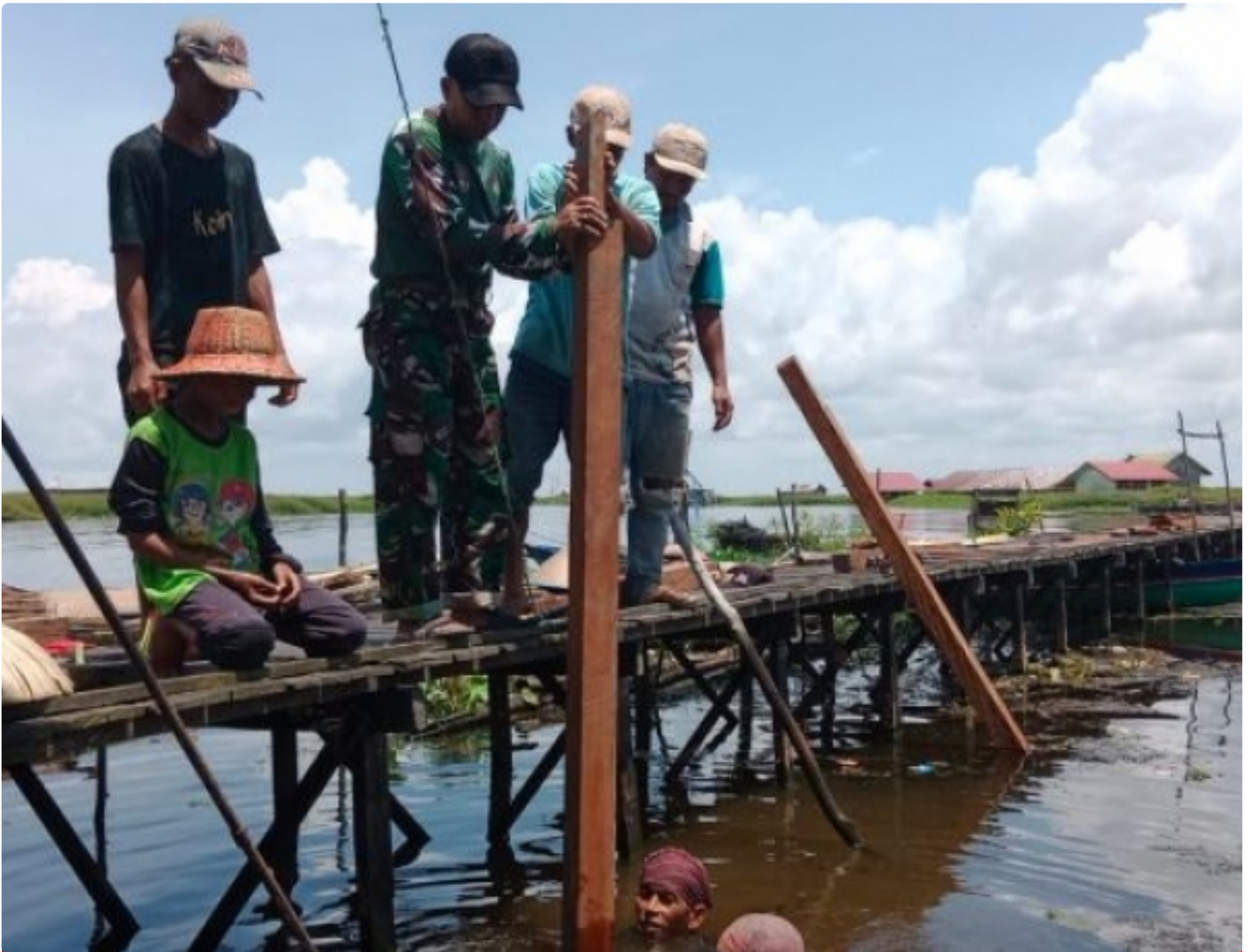
Pemasangan Tiang Penampungan Air
